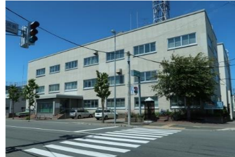
〈現庁舎：本庁舎（上）／西庁舎（下）〉
